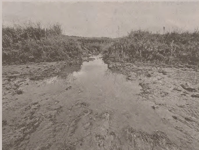
Nem bírta a terhelést és átszakadt a víztározó fala
